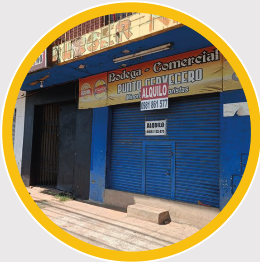
En el área de influencia por las obras del Metrobús abundan los cárteles de alquiler y vendo, evidencias de que el comercio fue “asesinado” por las autoridades (2022).
